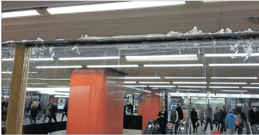
Unter anderem an den Rolltreppen zu den Stadtbahnhaltestellen wurde das Gel auf Absperrungen aufgetragen. Mittlerweile hat die Stadt den Einsatz untersagt, das Mittel wurde entfernt. Fotos: Peta
