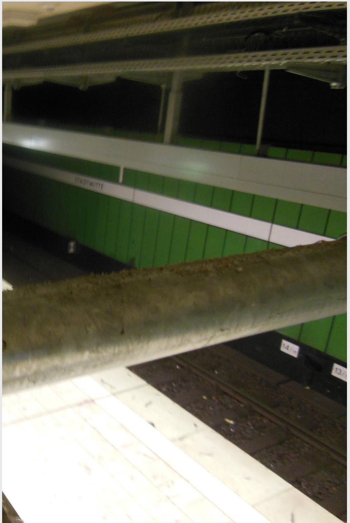
Auf dem Rohr ein Pastenstrang mit Nopaloma-Paste, mit Quarzsand abgestreut - Unten der Bahnsteig, Blick rechts: Gleisanlage.
