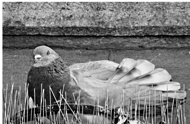
Abbildung 4: Die abgebildete Taube brütet hinter einem mangelhaft montierten Spikesystem mit scharfen Spitzen, an dem sich die Adulttiere und die Nestlinge verletzen können.
